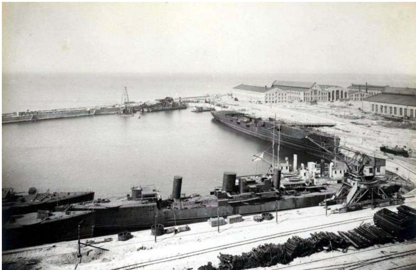
Рис. 7. Начало строительства крейсера "Профинтерн".
