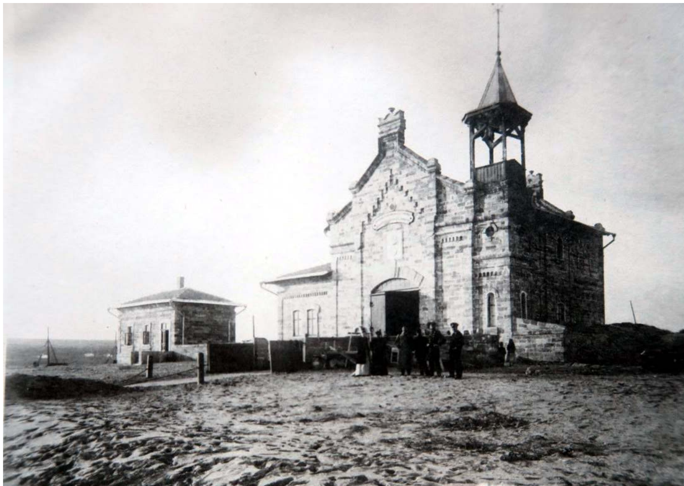
Рис. 2. Спасательная станция «Контр-Адмирал П.А. Зеленой».
